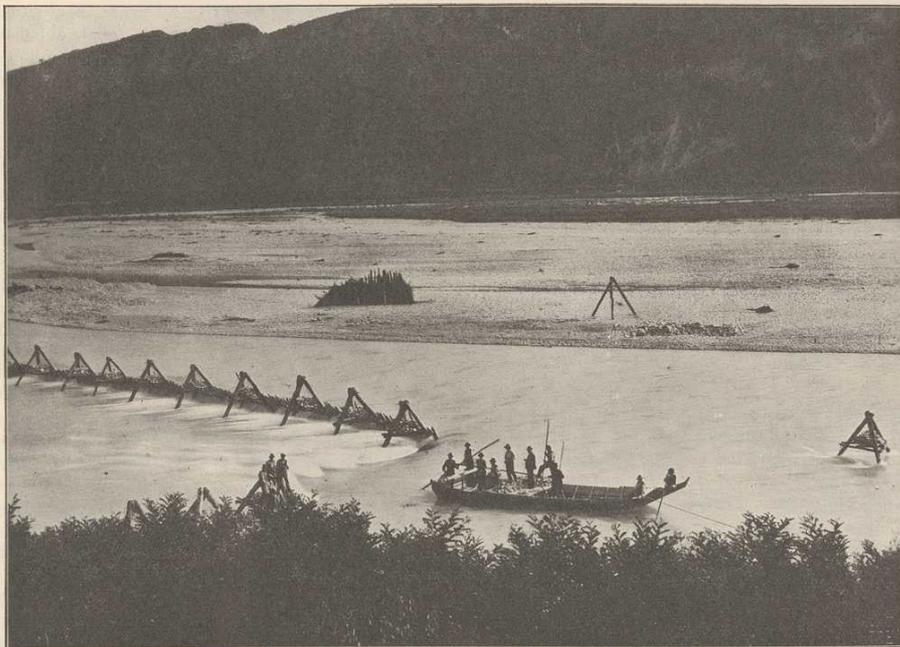
FIG. 4 — Antichi sistemi di presa con trippode (tutt'ora in uso sul Brenta).
