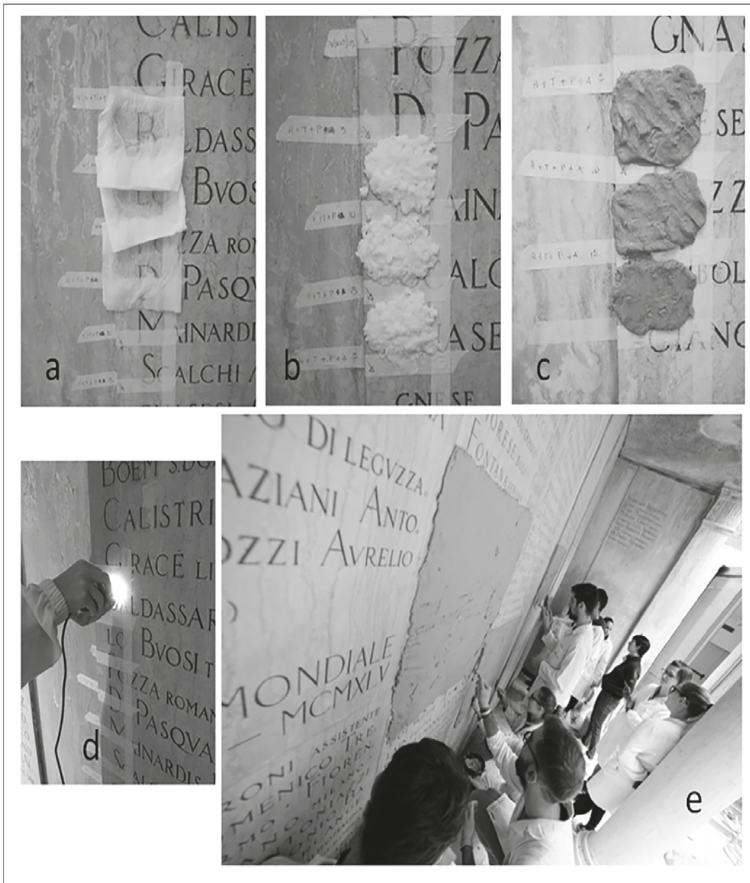
Figura 2 Test di pulitura effettuati sulle lapidi: prodotti applicati direttamente su carta (a), in impacco con polpa di cellulosa (b) e con polpa di cellulosa e sepiolite (c). Dopo la fase di controllo dell'efficacia (d) si passa all'applicazione su aree estese dell'impacco pulente (e)
