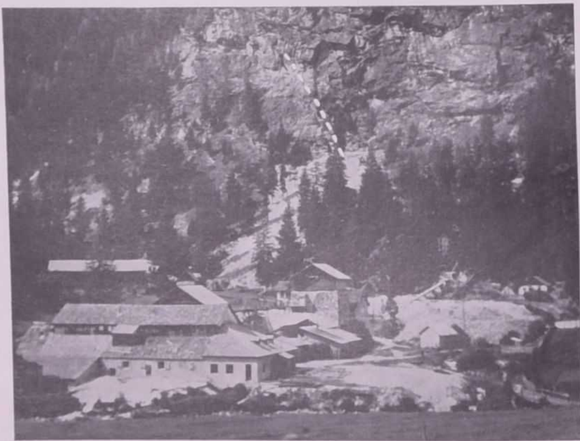
Fig. 7 - Gli edifici della miniera e la rupe nella quale ha inizio il giacimento. Col tratteggio bianco è indicata la frattura che racchiude la parte iniziale del filone.
