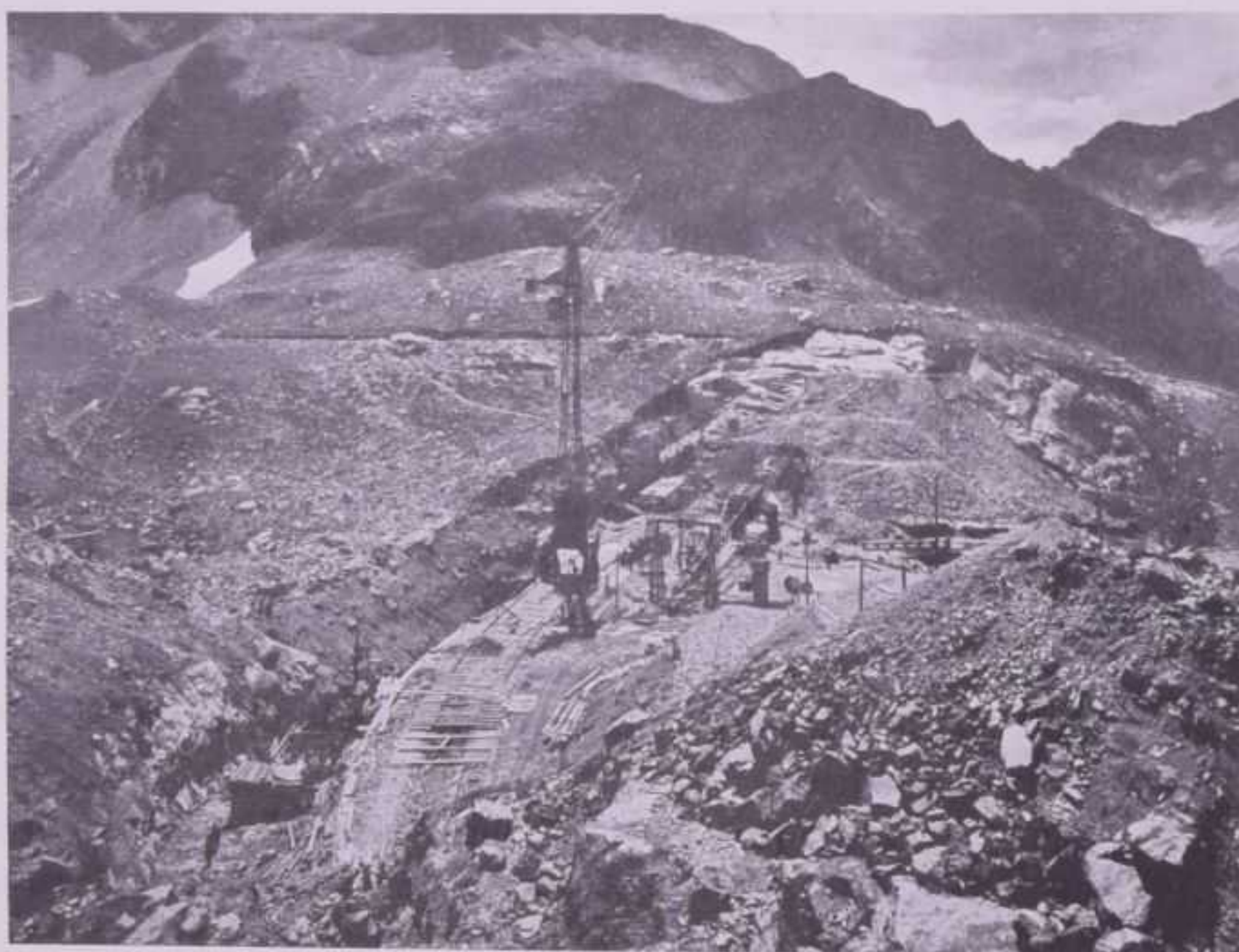
FIG. 2. - Scavi di fondazione per la diga principale quasi ultimati. Sono particolarmente visibili il fondo e il fianco sinistro della sezione d'imposta.
