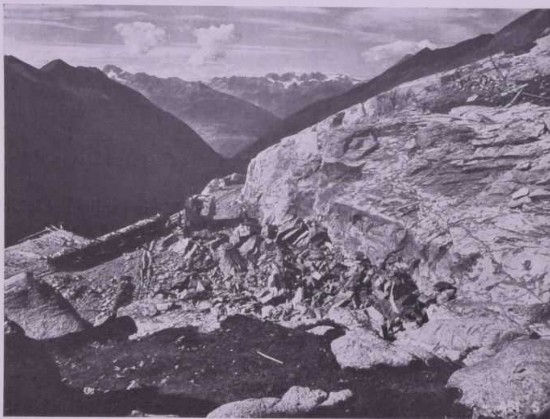
FIG. 3. - Cava di pietrame negli gneiss chiari, dalla quale sono stati ricavati gli inerti per i calcestruzzi. La cava si trova a sinistra della sella sud-occidentale del circo di Publino.
